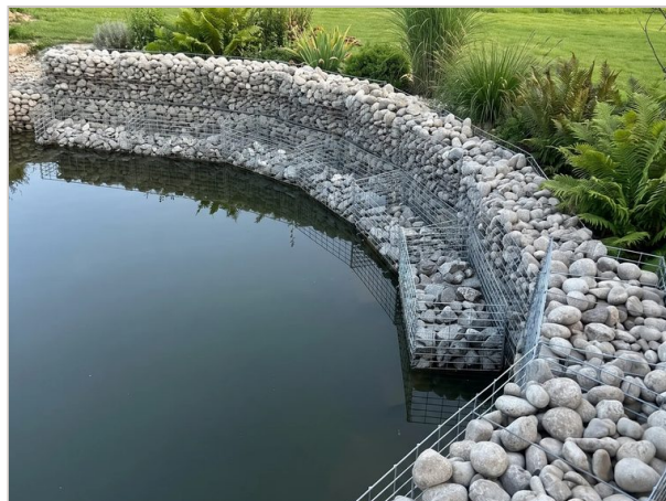
Kosze gabionowe z otoczakiem — umocnienie brzegu stawu
